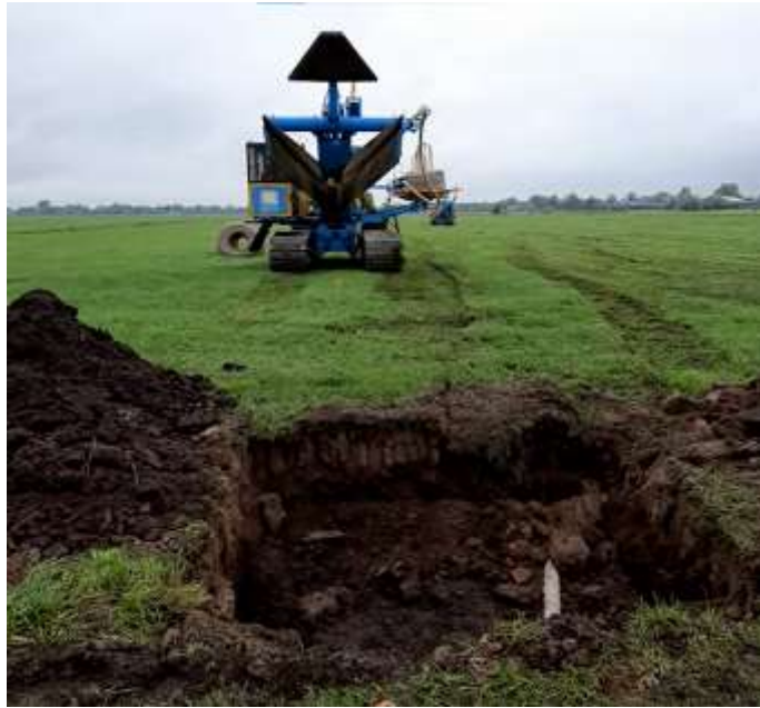
Figuur 18: De aanleg van DD waarvoor de bodem vergraven moet worden. (Bron: Stichting Blauwzaam, 2021)
